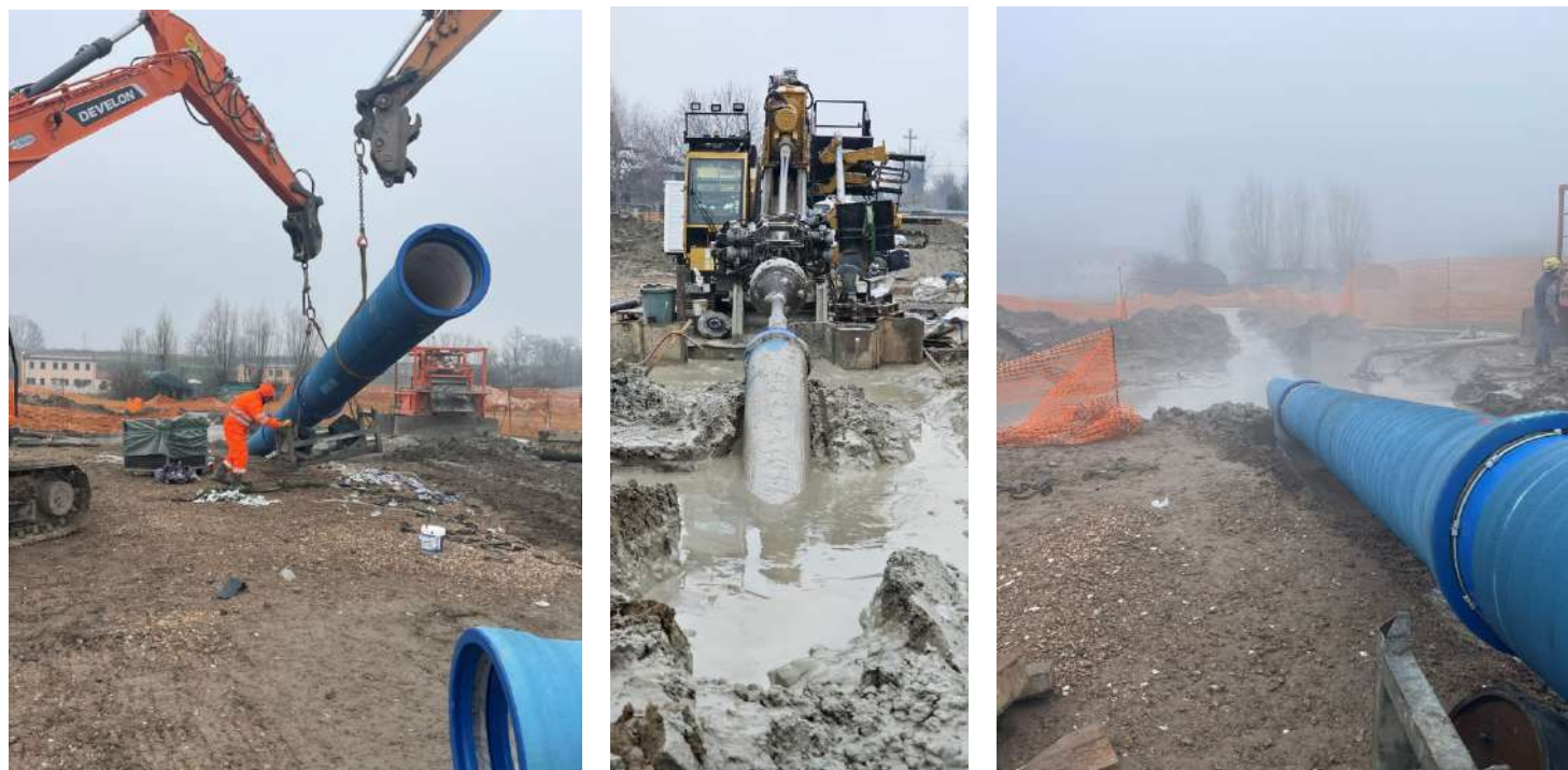
Figura 13 – cantiere lato montaggio tubazioni e lato rig (perforatore)
