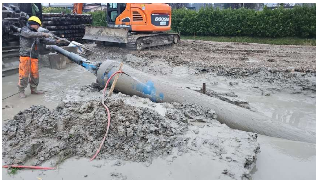
Figura 14 – fuoriuscita tubazione dal lato del rig (perforatore) operazione di varo in traino completata
