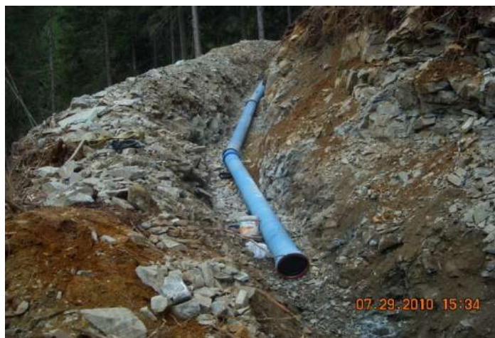
Figura 11 – resistenza meccanica del rivestimento esterno in malta di cemento
