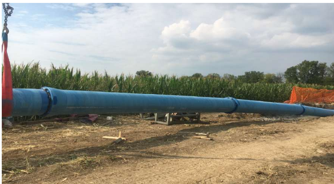
Figura 10 – esempio di resistenza del giunto antisfilamento VRS-T per tubazione DN600
