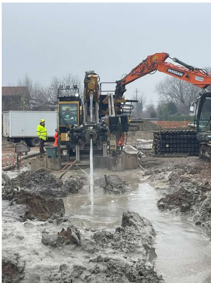
Figura 15 – lato del rig (perforatore)
