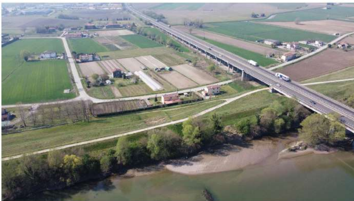
Figura 1 – Vista da Nord-Est verso Sud-Ovest dell'area in sponda destra tra l'autostrada A13 e via O. Munerati (in comune di Rovigo) interessata dall'intervento fonte studio Hydrodata
