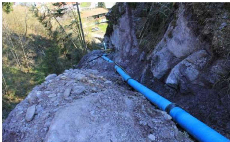
Figura 11 – resistenza meccanica del rivestimento esterno in malta di cemento
